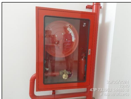
ภาพที่ 32 ตู้สายฉีดน้ำดับเพลิง
