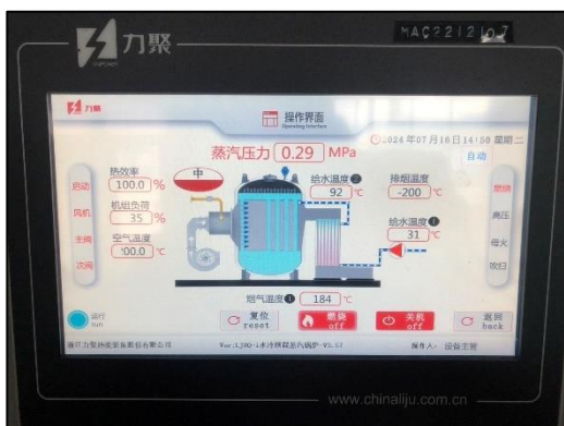
ภาพที่ 41 มาตรวัดระดับน้ำและความดันหม้อน้ำ
